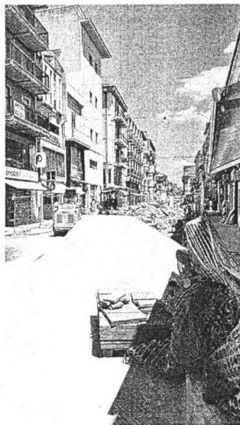
Via Roma è di nuovo un cantiere
